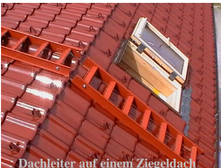
Dachleiter auf einem Ziegeldach
